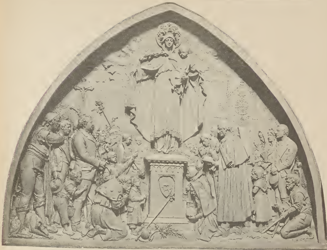
TÍMPANO DE LA PORTADA EN LA IGLESIA DE CASTELLAR, obra de D. Rosendo Nobas
